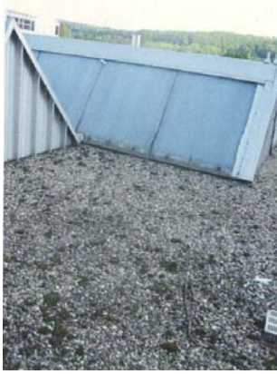
Abbildung 9: Shedeindeckungen vor der Sanierung
