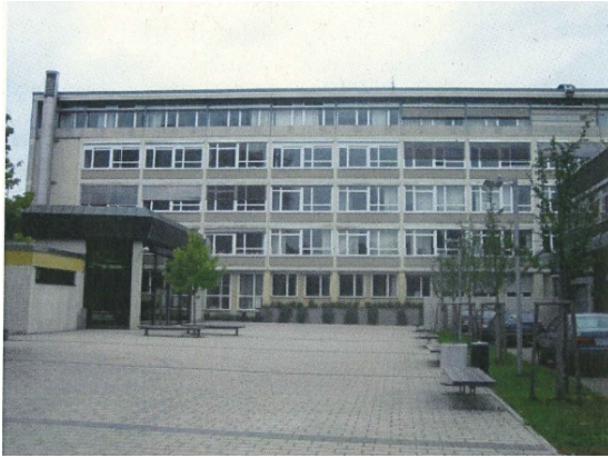
Abbildung 12: Bau E vor der Sanierung
