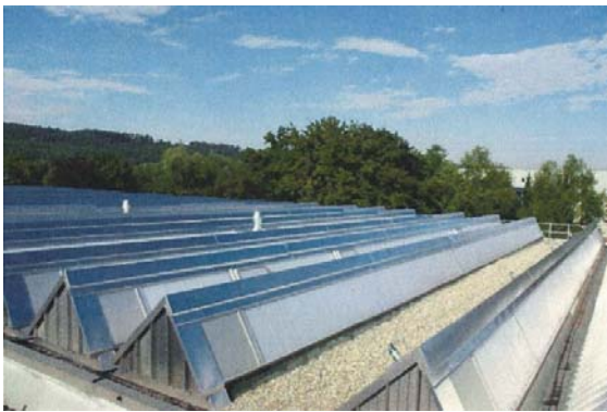
Abbildung 11: Sheddach nach der Sanierung
