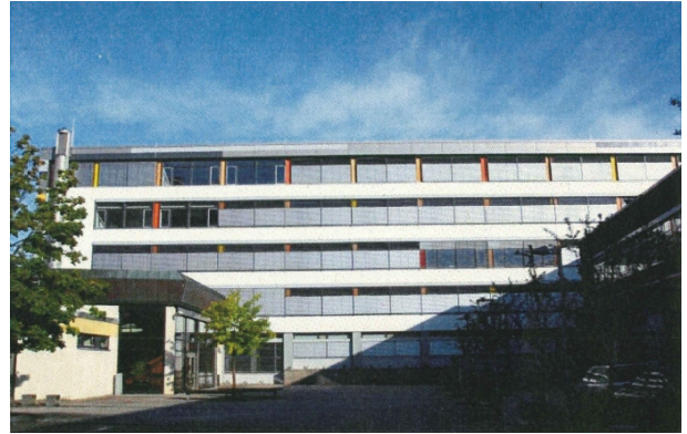
Abbildung 13: Bau E nach der Sanierung
