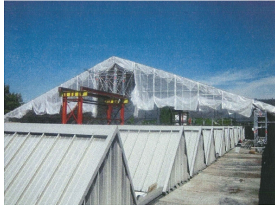
Abbildung 10: Während der Sanierung mit Wetterschutzdach
