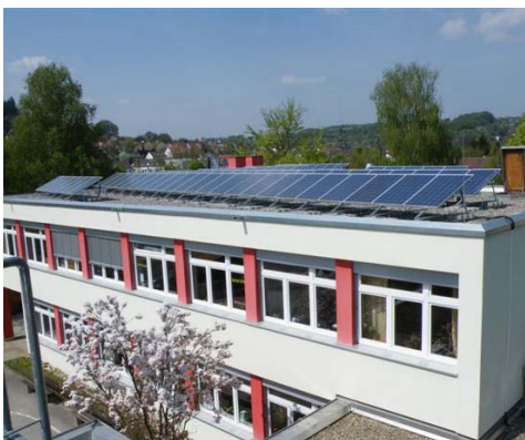
Abbildung: Photovoltaikanlage Bodelschwingschule Nürtingen 2008
